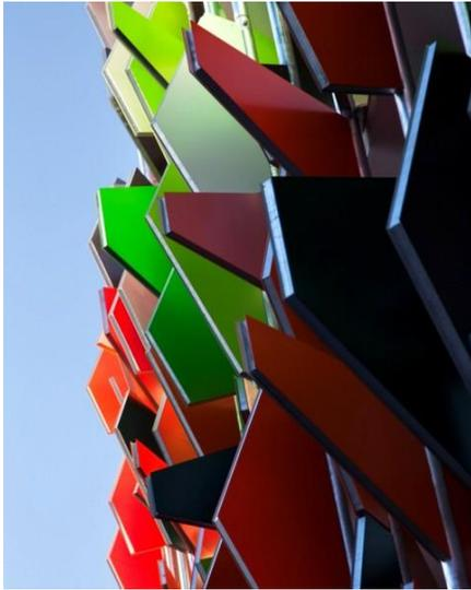
La construcción de cuatro pisos cuenta con un diseño innovador capaz de alcanzar la neutralidad de carbono. Incluye sistemas de inodoro al vacío, persianas fijas con dispositivos de sombreado, cristales dobles en las ventanas y pocos cajones de estacionamiento para autos, con el fin de promover otras formas de transporte.
