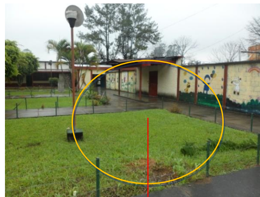
Caminamientos utilizados como plazas.
