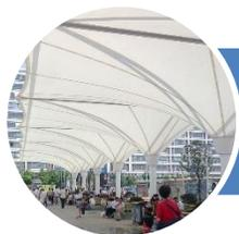
Cubierta: Membranas de PVC
