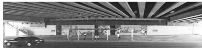
Fotografía de ubicación de lugar, Fotografía actual (2011)
