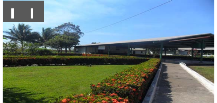
Modulo Habitacional San Patricio
