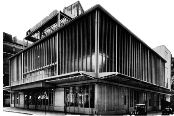
Imagen 8: Fuente. Maison du Peuple, Arquitectura – Industrial – Jean Prouvé-L'Yxel.
