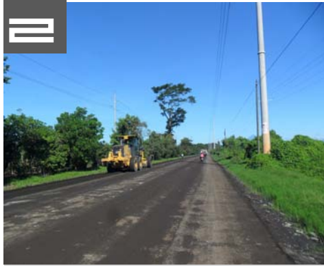
Calle principal— Parcelamiento pilar
