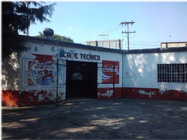
CAFETERÍA (INGRESO) IMAGEN 74 Fuente: Propia
