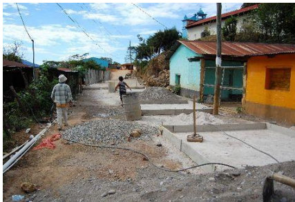
Fuente: panoramio.com Fotografía que muestra la introducción de agua potable, energía eléctrica y pavimentación de calles del municipio.
