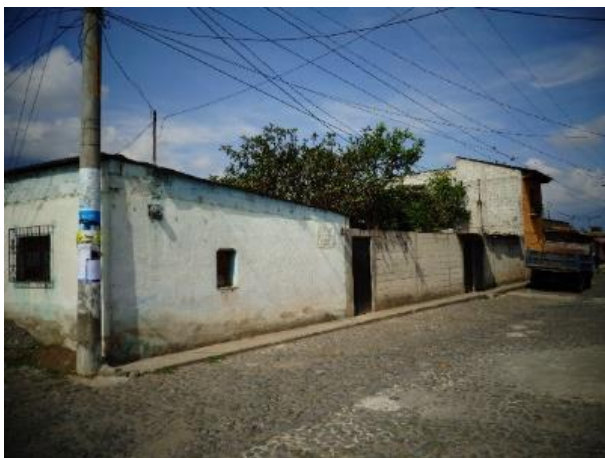
Ilustración 15: Vista de la vivienda sobre la Elevación de fachadas de acceso sur y donde inicia la plaza de la aldea. . Foto Jorge Sarg; 201
