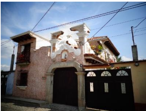
Ilustración 12: Esta construcción de segundo nivel muestra una serie de detalles constructivos coloniales que alteran y deterioran la imagen del ingreso a la Aldea, está ubicada en la elevación de calle de acceso norte, en su estado actual. . Foto Jorge Sarg; 2014
