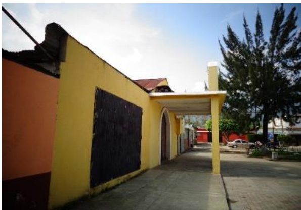
Ilustración 3: toma fotográfica del estado actual de parte de elevación lateral norte del templo, se proyecta las columnas que sostienen la terraza y el campanario. Foto Jorge Sarg; 2014
