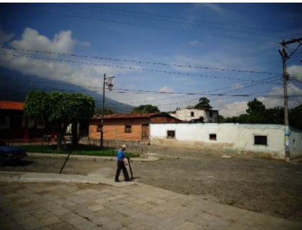
Ilustración 18: Parte de la Elevación Poniente hacia el sur, estas viviendas se construyeron después del terremoto de 1976; su fabricación está realizada con ladrillo visto y nótase el refuerzo vertical y horizontal, faltando el recubrimiento al muro para su preservación.
