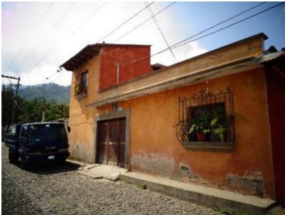
Ilustración 14: el deterioro de la imagen visual creada por esta construcción de segundo nivel rompe con el lineamiento original de la fachada de esta vivienda. Foto Jorge Sarg; 2
