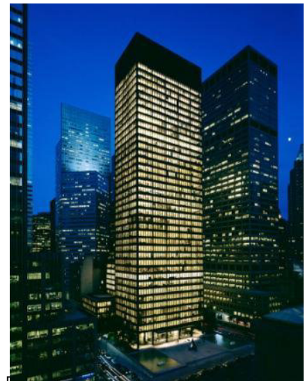
Fotografía 2. de: Torre de oficinas (1958) Seagram building en NY http://aprendiendo sociales.blogspot.com
