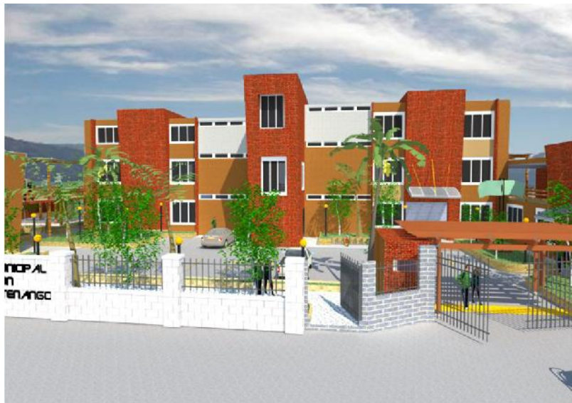
4. FACHADA DE TALLERES
