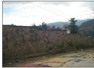
(Foto 11) VISTA EXTERIOR OESTE Y MURO PERIMETRAL DEL TERRENO
