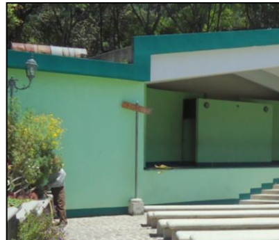
Acabado en muro de mampostería: Repello, Cernido más Pintura.
