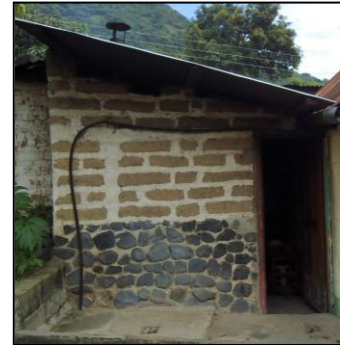
Acabado en muro de adobe y piedra: materiales vistos.
