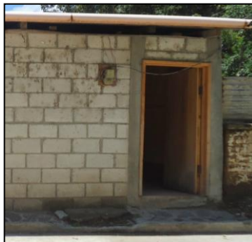
Acabado en muro de mampostería: Block visto.
