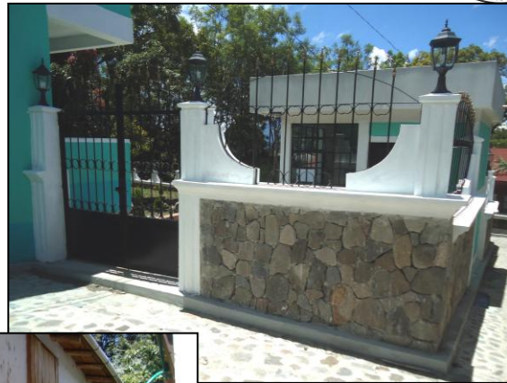
FOTOGRAFIA No. 21 Construcción de piedra tallada estructurada, Combinada con concreto y metal Tomada por: Diana Carolina Muñoz.
