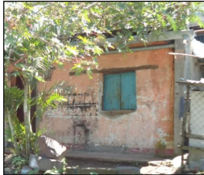
Acabado en muro de adobe: Encalado y pintura
