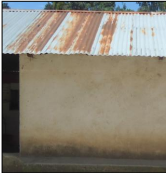
Acabado en muro de adobe: Encalado
