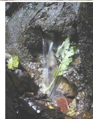
Fotografía no.28 Tanque de captación de aguas de manantial y nacimiento de agua. FUENTE: Diana Carolina Muñoz
