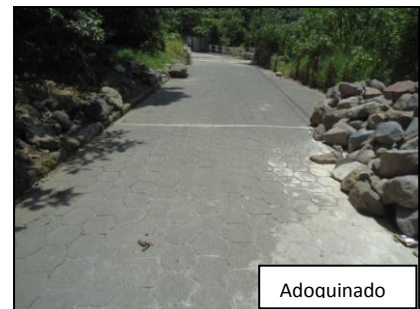
FOTOGRAFÍAS No.16: Tipos de materiales utilizados en vías y calles. Tomadas por: Diana Carolina Muñoz
