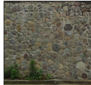
Acabado en muro de mampostería: Piedra de Río cizada.
