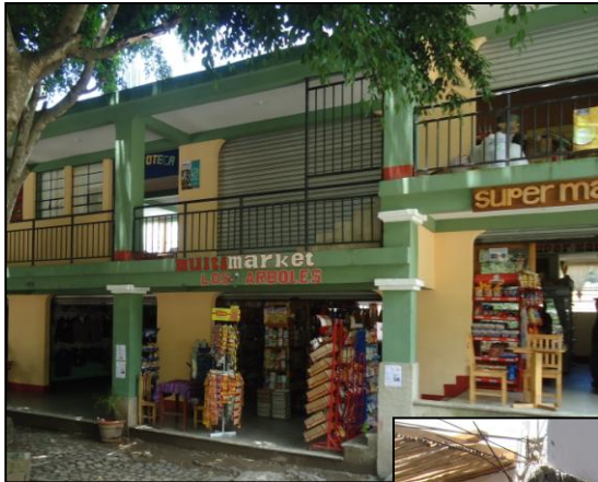
FOTOGRAFIA No.20 Construcción de block, y losa fundida. Tomada por: Diana Carolina Muñoz.
