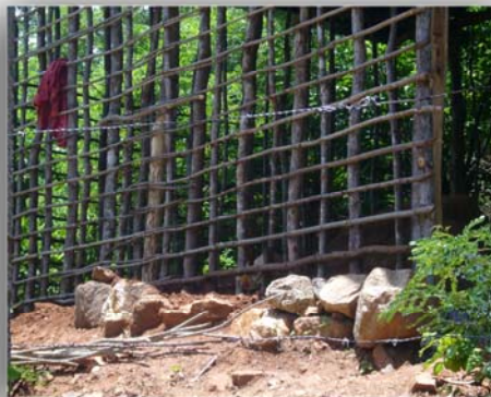
CONSTRUCCIÓN TIPO VERNACULA DONDE SE USAN EN COLUMNAS TRONCO DE ARBOL ROLLIZOS Y TENDALES DE RAMAS EN LOS MUROS, EN TECHO ESTRUCTURA DE MADERA SIEMPRE DE TRONCOS ROLLIZOS, ASI MISMO BARRO COMO RECUBRIMIENTO PARA FORMAR EL MURO DE MAMPOSTERIA
