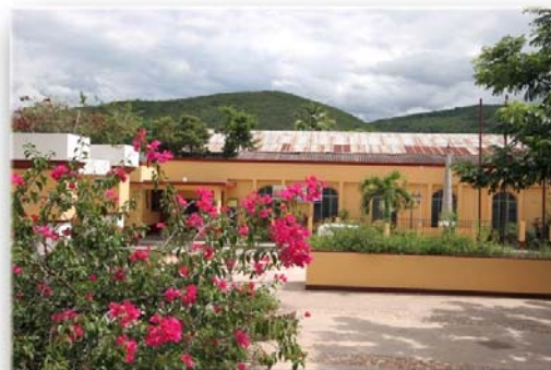
FACHADA PRINCIPAL MUNICIPALIDAD DE SAN AGUSTIN ACASAGUASTLAN
