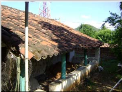
VIVIENDA TIPO COLONIAL USO DE TEJA EN TECHO COLUMNAS DE MADERA MUROS DE ADOBE
