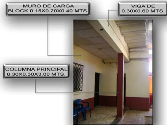
Fotografía: elaboración propia Ubicación: interior del edificio municipal. Corredor y área de espera.
