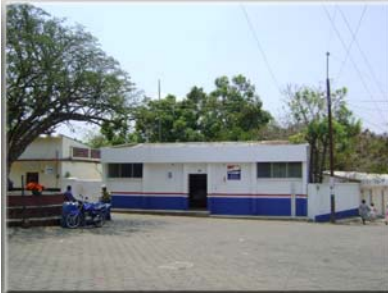
EDIFICACIÓN TIPO MODERNA USO DE LAMINA DE ZINC EN TECHO COLUMNAS DE CONCRETO MUROS DE BLOCK
