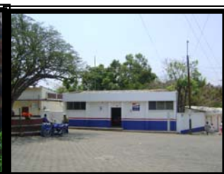
Fotografía 4 Edificación con materiales: block, concreto y lámina de zinc.
