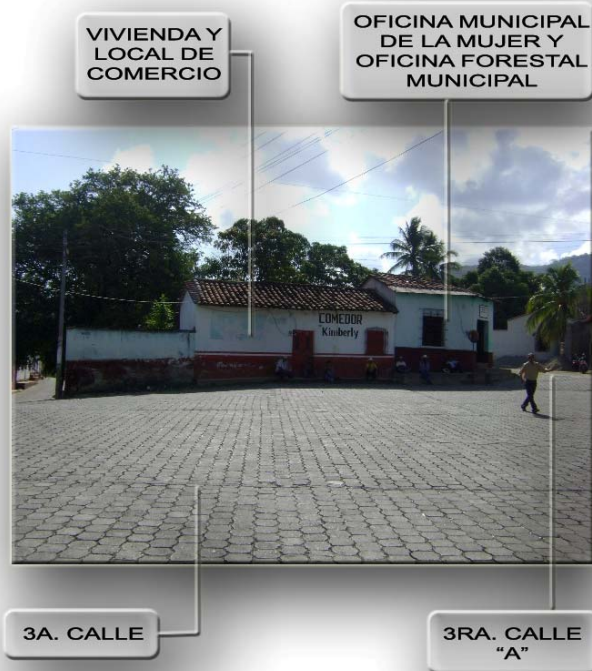
FOTOGRAFÍA: ELABORACIÓN PROPIA Vista frontal del inmueble donde se ubican ambas oficinas, sobre la 3ª. Calle, y 3ª. Calle "A".
