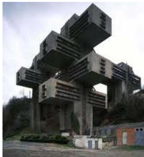
FOTO No. 5 y 6 FUENTE: google.com.gt
