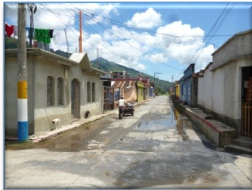
FOTOGRAFÍA No.13 ÁREA HOMOGÉNEA 3
