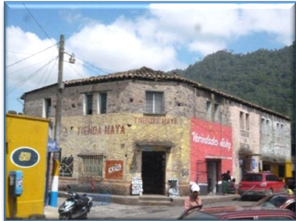
FOTOGRAFÍA No. 27 EDIFICIO CONSTRUIDO EN PIEDRA
