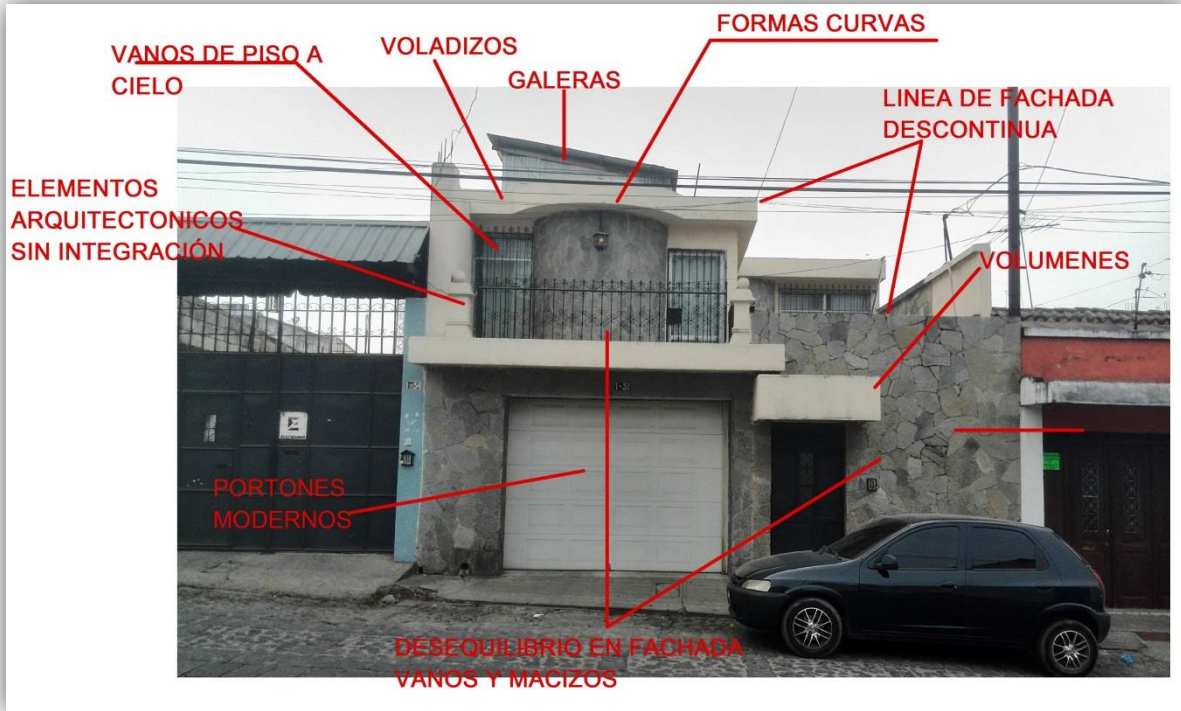
IMAGEN No. 99. IDENTIFICACIÓN DE ELEMENTOS DISCORDANTES EN EL EJE 12 AVENIDA.
