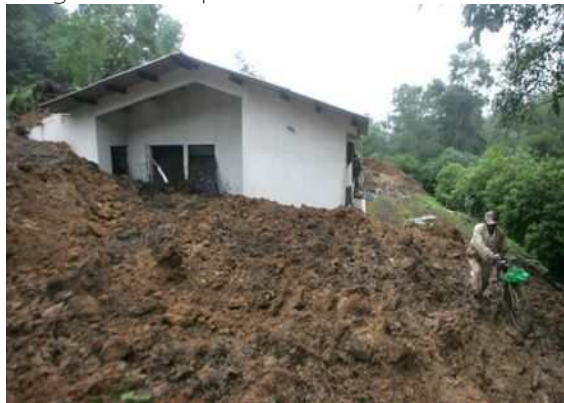
Foto 03. Vivienda parcialmente destruida por un deslizamiento de tierra, ocurrido durante la tormenta Stan. Fuente: CONRED.
