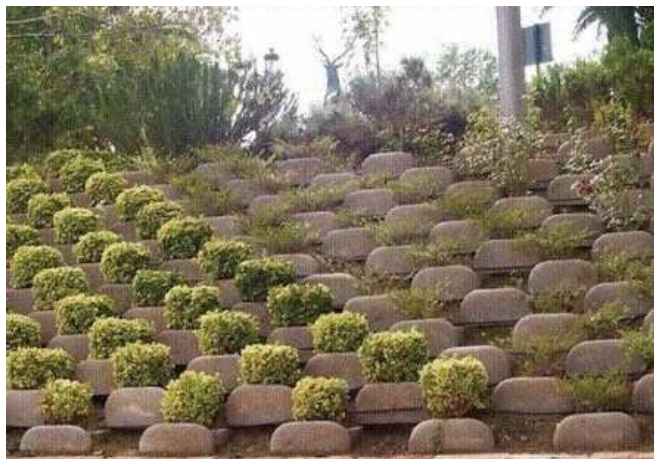
Foto No. 4 vegetación en taludes. Fuente: www.miranda.evisos.com.ve
