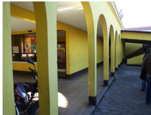
Corredores con vista hacia patio interior.
