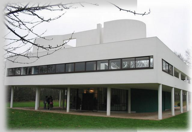
Imagen 11. Villa Savoye Fuente: Fotografía http://www.plataformaarquitectura.cl/2010/11/02/villa-savoye-le-corbusier/
