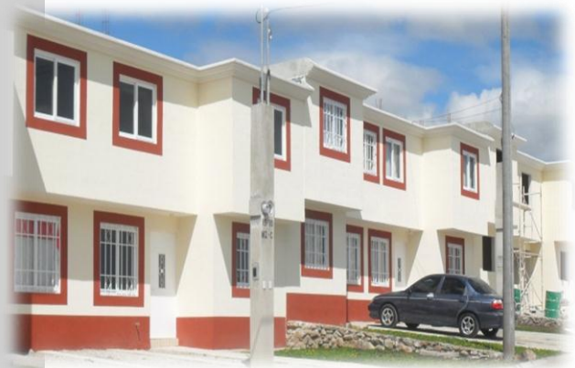
Imagen 4. Arquitectura existente Colonia Valle del Norte Fuente: Elaboración propia.
