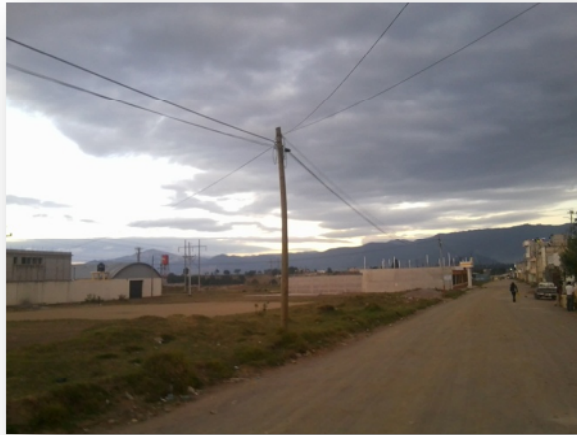
Líneas Eléctricas sobre 11 Calle.
