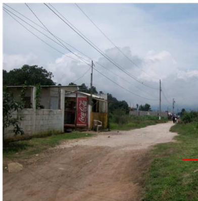
RED MUNICIPAL DE ELECTRICIDAD (DISPONIBILIDAD PARA ACCEDER A SERVICIO ELECTRICO)
