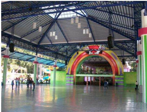
COLUMNAS DE CONCRETO REFORZADO, JOIST, RETÍCULA ESPACIAL Y CUBIERTAS LIVIANAS EN SALÓN DE USOS MÚLTIPLES EN PLAZA ALEGRÍA
