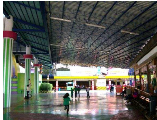
COLUMNAS DE CONCRETO REFORZADO, JOIST, RETÍCULA ESPACIAL Y CUBIERTAS LIVIANAS EN SALÓN DE USOS MÚLTIPLES EN PLAZA ALEGRÍA
