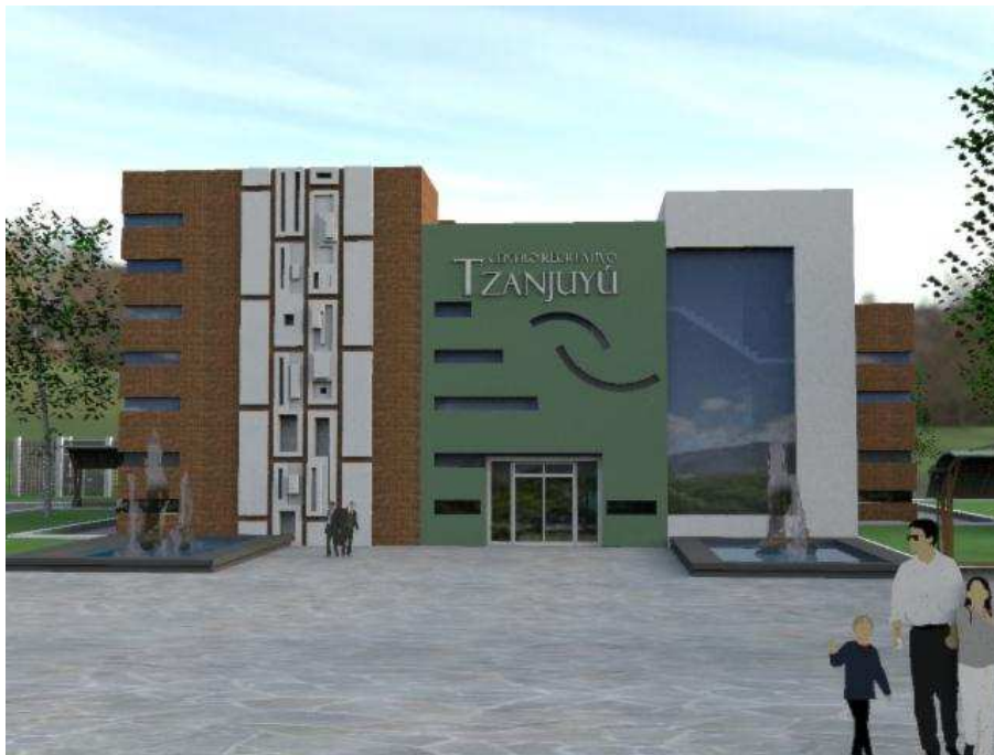
EDIFICIO DE SALONES DE USOS MÚLTIPLES FACHADA PRINCIPAL (SUR-OESTE)
