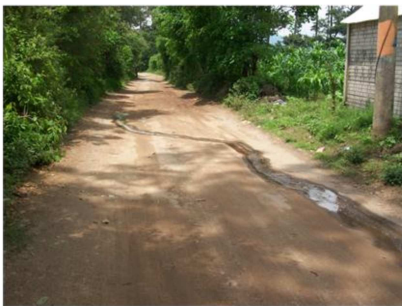
DESFOGUE SUPERFICIAL DE AGUAS PLUVIALES Y JABONOSAS FOTO PROPIA IMAGEN No. 5
