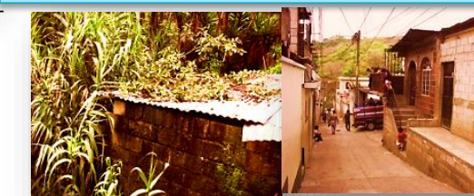
Figura 80. Vistas exteriores de vivienda No. 2. (De León S. 2013)
