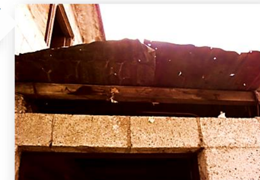
Figura 76. Parte de fachada exterior vivienda No. 2 (De León S. 2013)
