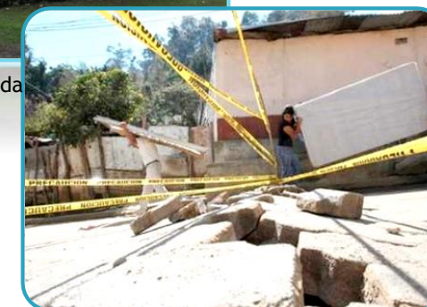
Figura 55. Fotografía de viviendas en sector popular, afectadas por los hundimientos de 2011. (De León S. 2013).
