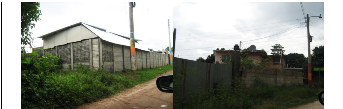
Fotografía No.15, 16: Infraestructura existente en el lugar Fuente de consulta: Propia
