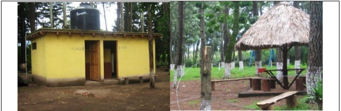
Fotografía No.18, 19: Estructuras existentes en el terreno Fuente de consulta: Propia
