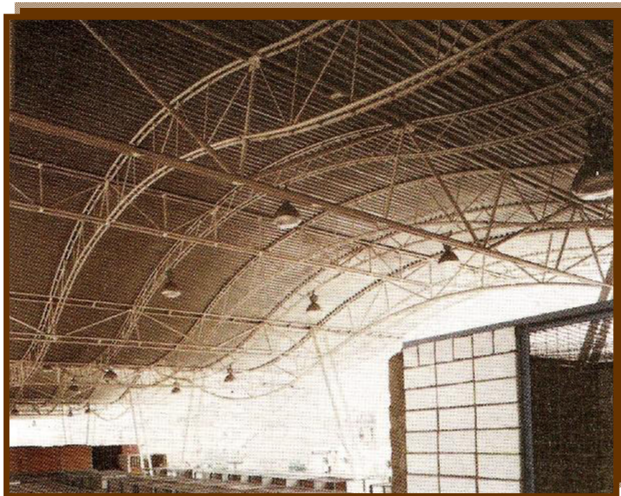
Imagen No. 21. Estructura portante. Mercado Pino Suarez , D.F. fuente : biblioteca virtual UNAM.
