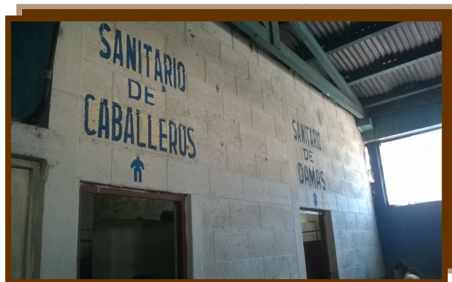
Imagen No. 18. Muros del mercado actualmente. Fuente. elaboración propia
