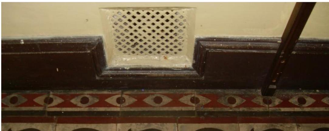
Fig. 34 Sistemas de ventilación utilizada para evitar humedad, la cual ha dado resultados, porque el edificio tiene muy poca humedad. Fuente: K. Solórzano, 2012.
