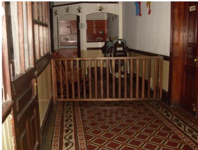
Fig. 16 Pasillo hacia ingreso principal, el cual ha tenido varias adaptaciones, baranda de madera para delimitar área de sala cuna, y tabicación de tablayeso para el área de cambiado de bebes. Fuente: K. Solórzano, 2012.
