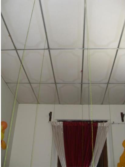
Fig. 25 Adaptación de cielo falso en dormitorios, actualmente aulas escolares. Fuente: K. Solórzano, 2012.
