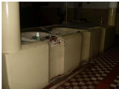
Figs. 16 y 17 Reparacion de la pila, actualmente deshabilitada, y que se está deteriorando por encontrarse sin ningun uso, la cual está tapada con planchas de fibra de vidrio para evitar que los niños tiren objetos o se lastimen.
