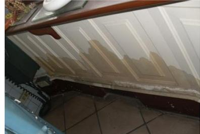
Figs. 40 y 41 Detalle de humedad e instalaciones eléctricas en madera de sillares.
