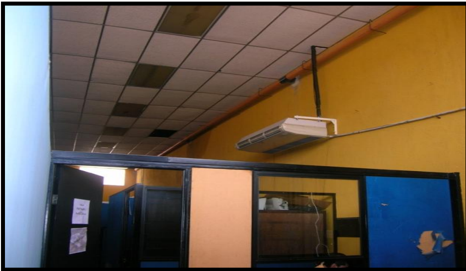
FOTOGRAFÍA 44/ Integración de tabiques de metal y madera y ventiladores aéreos
