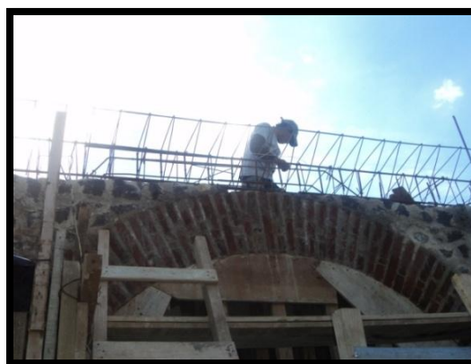
FOTOGRAFÍA No.6 integración de arco con ladrillo
