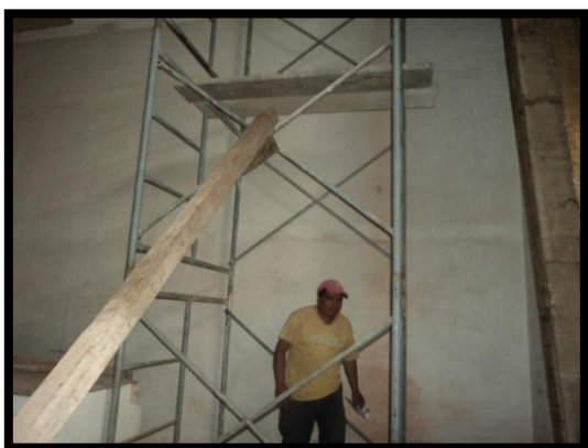
FOTOGRAFÍA No.5 integración de repellos ladrillo
