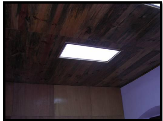
Se observa por el interior como quedo el techo
