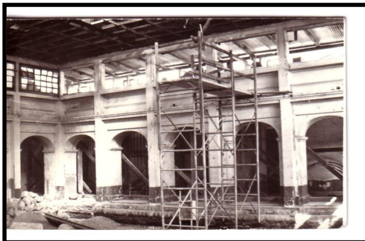
FOTOGRAFÍA No.1 Liberación de la estructura con láminas que cubre uno de los patios
