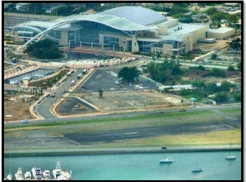
Fotografía B7 Vista Aérea, Centro de Convenciones Puerto Rico. 31
