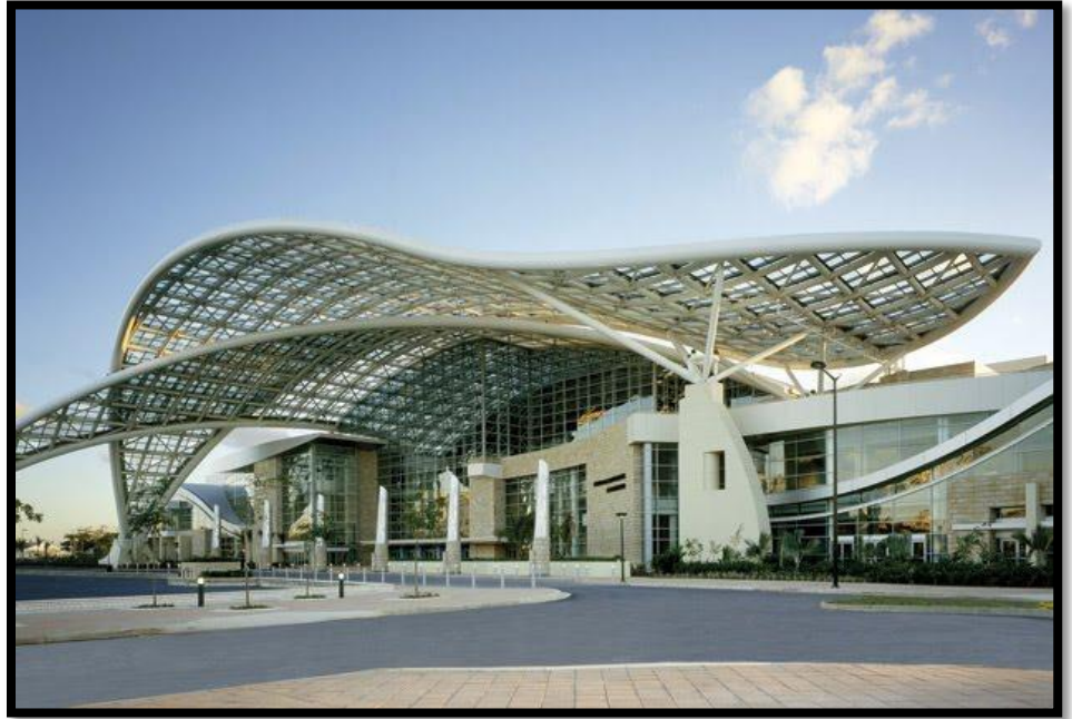
Fotografía B6 Fachada Principal, Centro de Convenciones Puerto Rico. 30
