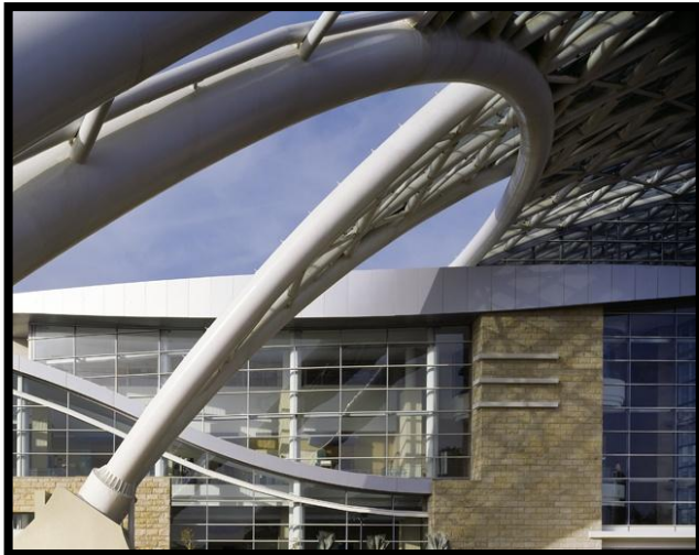
Fotografía B10 Sistema Constructivo, Centro de Convenciones Puerto Rico 34
