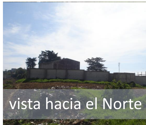
Fotografía propia. Septiembre 2012
