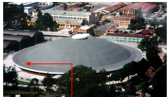
Fotografía No.3 Vista exterior.
