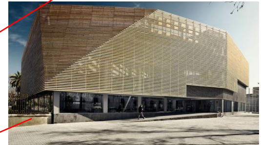
Fotografía No. 5 Vista exterior.
