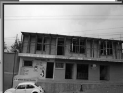
Se observa el sistema constructivo tradicional con block de pómez y losa de concreto reforzado
