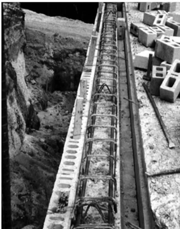
*Viga de remate en muro
