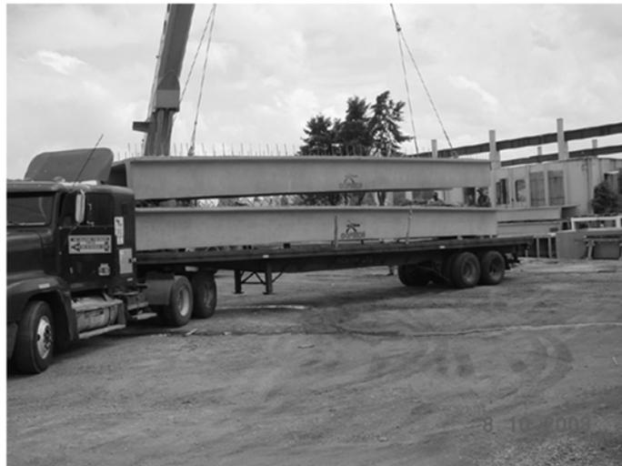
*Cargas en tráileres de los prefabricados*
