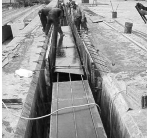
*Molde para prefabricado Doble T*
