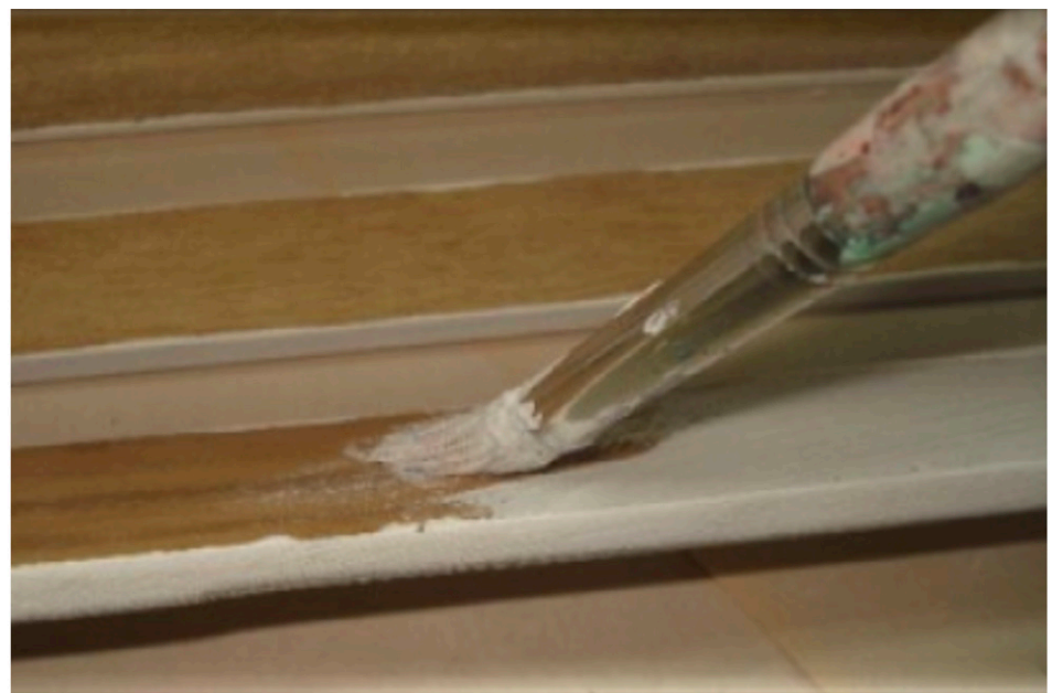
Imagen 40: Pintura en madera que cubre la Veta
