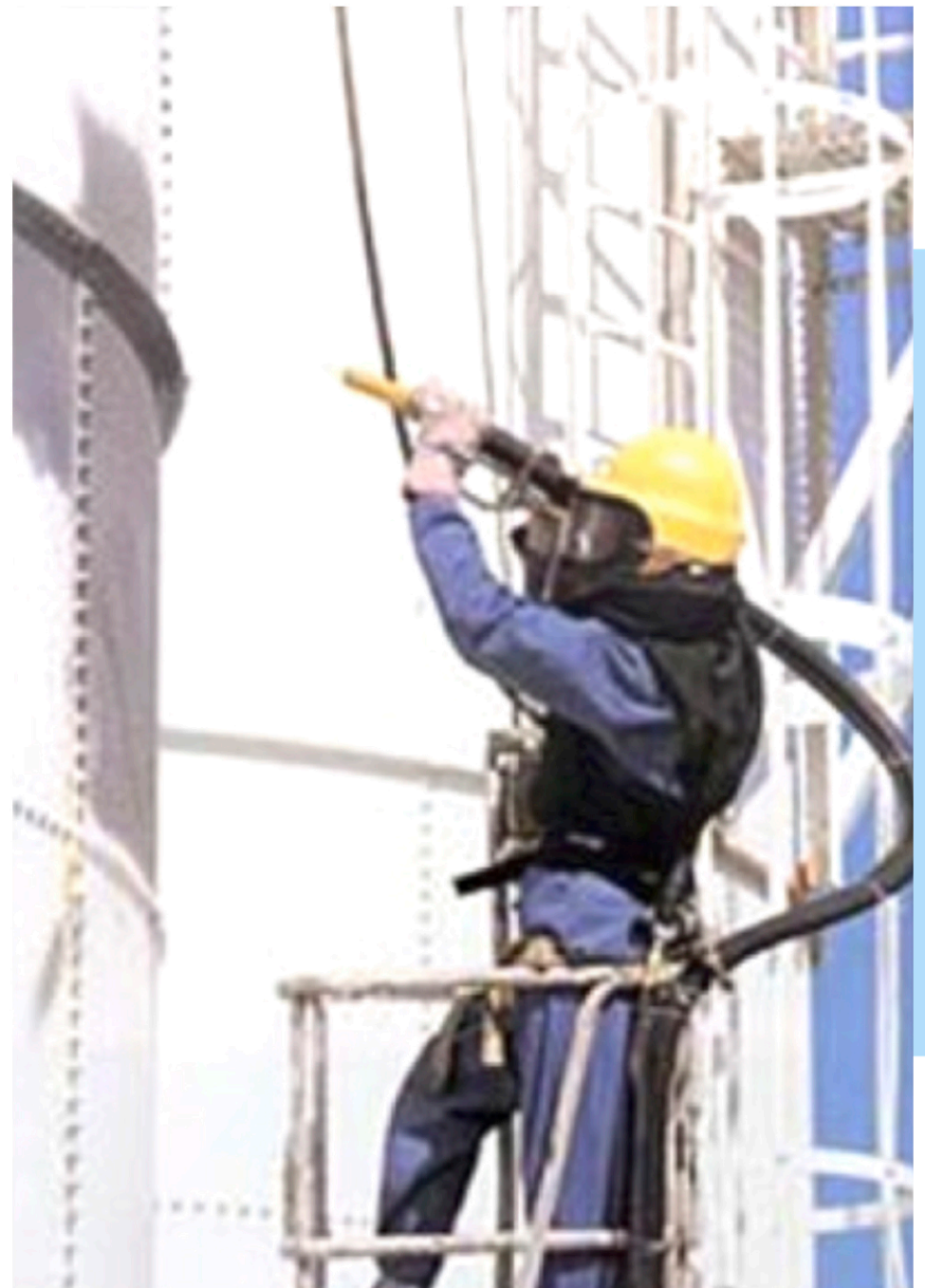
Imagen 44: Aplicación de Anticorrosivo en Metal
