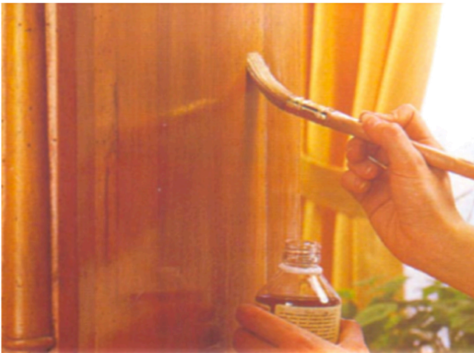
Imagen 37: Aplicación de barniz en una puerta en interior
