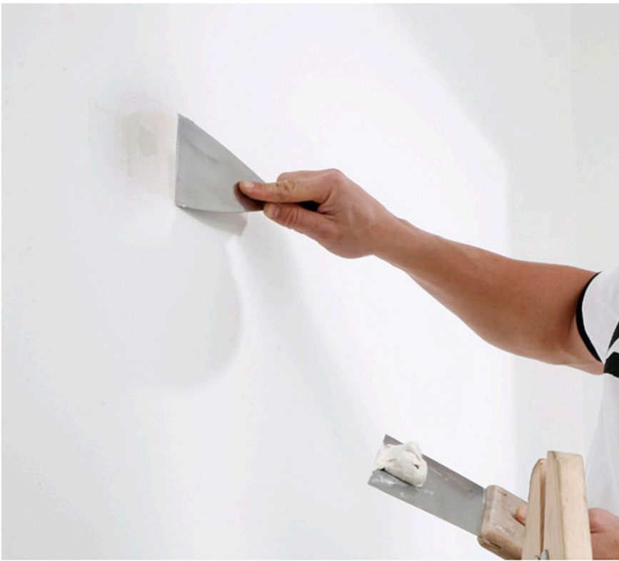
Imagen 55: Aplicación Tapagrietas
