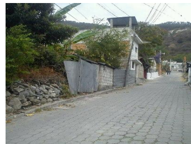
Fotografia 5 Acometida de agua potable. Fuente: Jairon Tumax, 2014.
