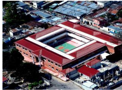
Fotografía 11. Escuela Oficial 810. (2013). Fuente propia.
