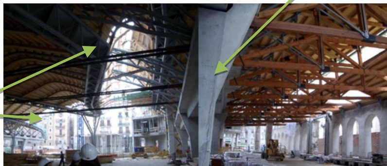
ESTRUCTURA DEL TECHO
