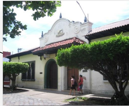
EDIFICIO DE CORREOS
