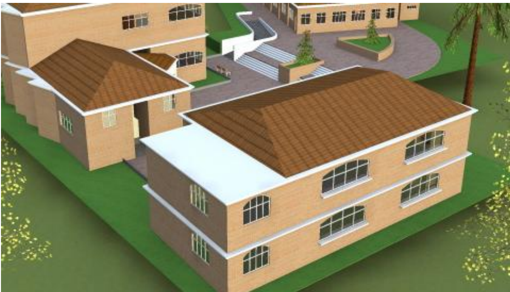
Vista posterior, edificio de talleres de cocina y repostería.
