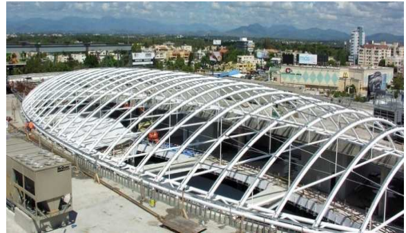
Imagen 102 Cubierta metálica centro comercial Ágora Mall
