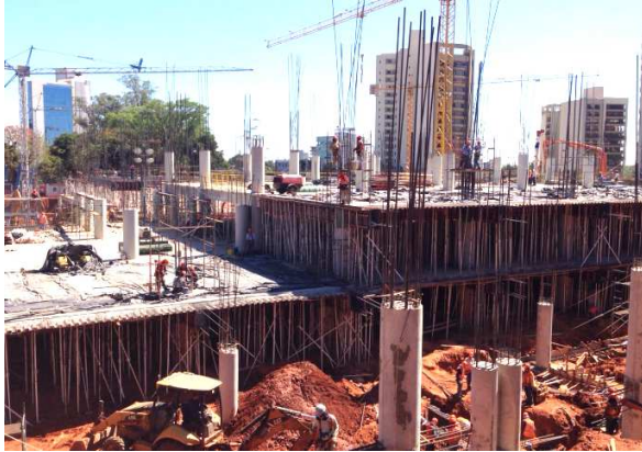
Imagen 30 Construcción Centro Comercial Paseo la Galería Paraguay (2014)
