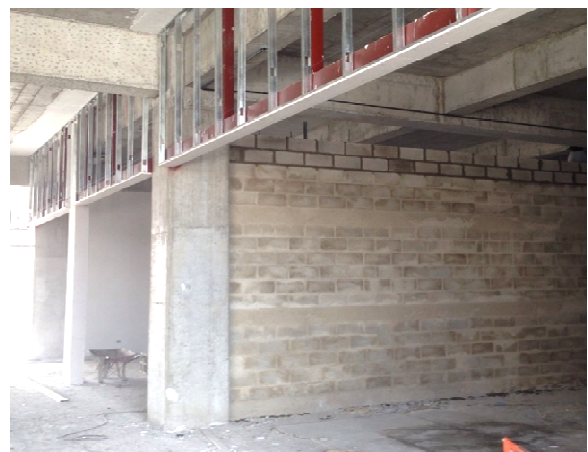
Imagen 82 Muro de block en división de locales
