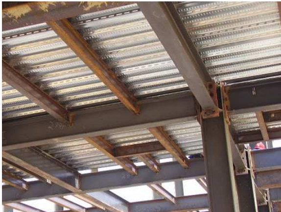
Imagen 94 Estructura metálica + Losacero
