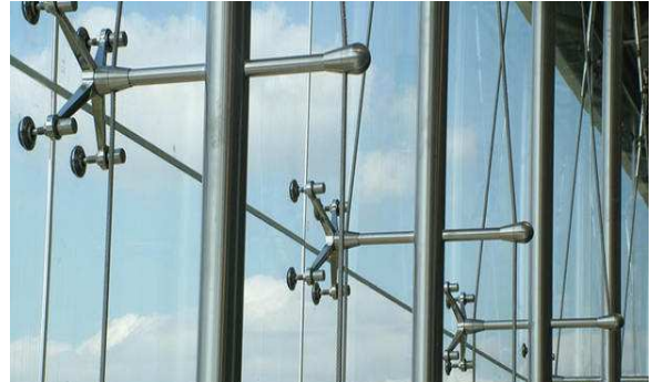
Imagen 89 Sistema de spiders o cristal estructural
