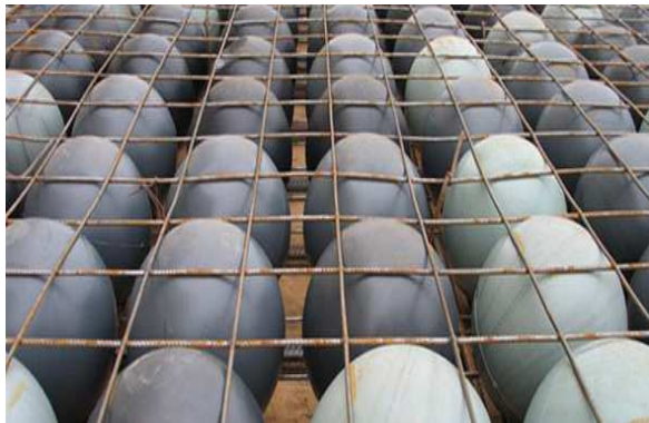
Imagen 101 Losa Aligerada con esferas plásticas
