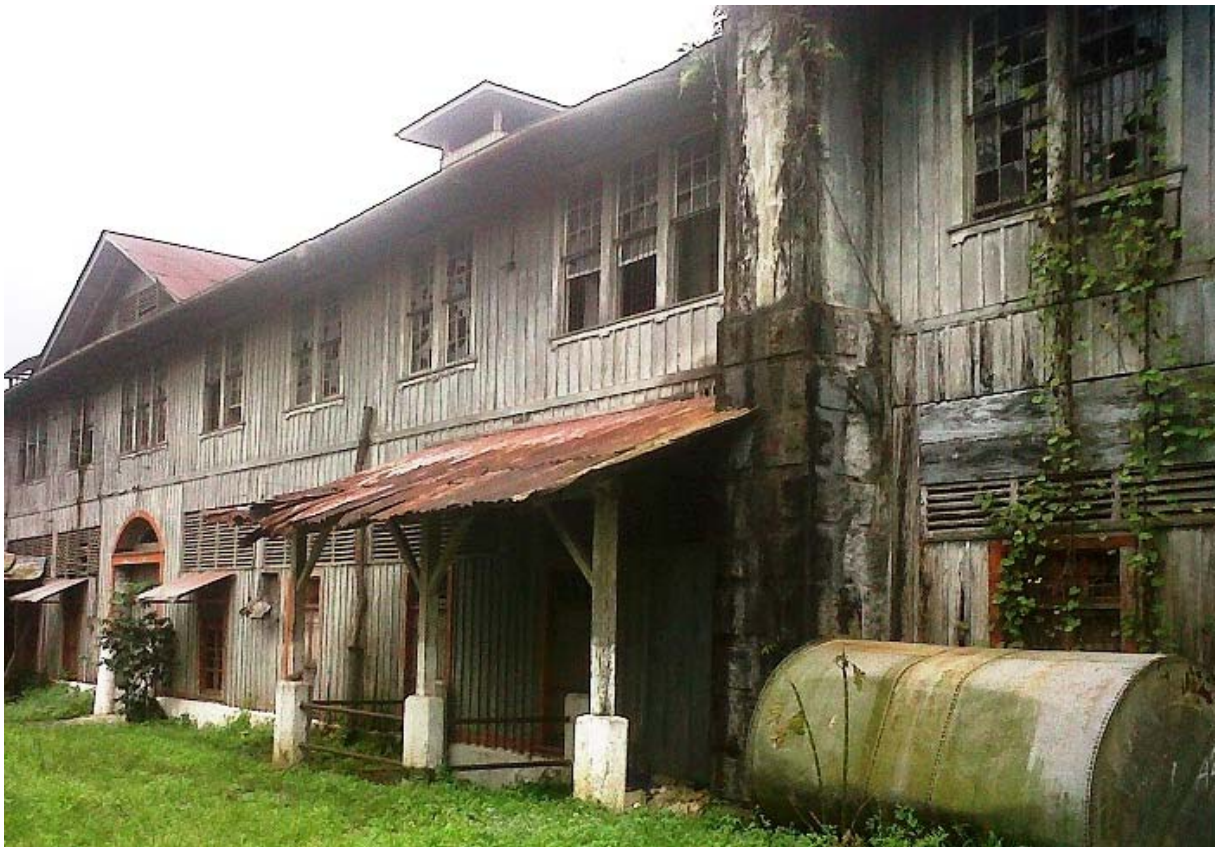
VISTA DE LA ELEVACIÓN FRONTAL DEL BENEFICIO
