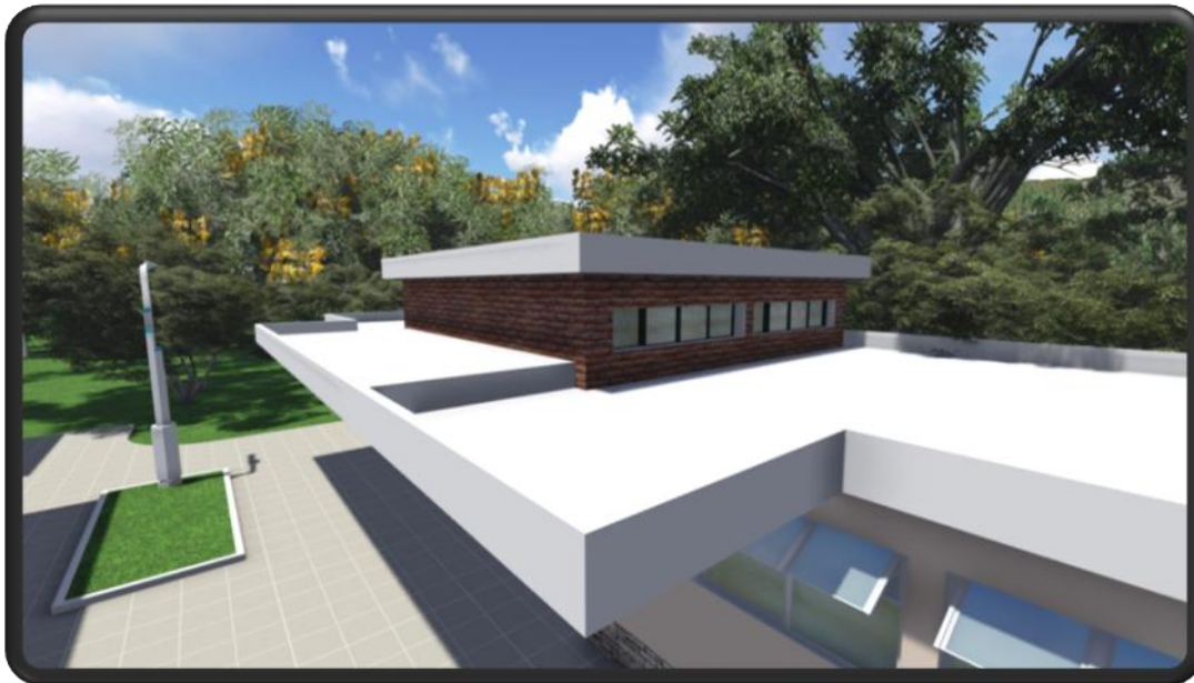
MÓDULOS DE AULAS
