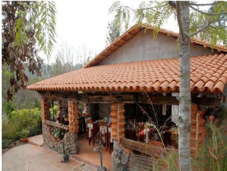
UTILIZAN CERRAMIENTO VERTICAL FORMAL HASTA LA PRIMERA SOLERA, DESPUÉS UTILIZAN MATERIAL BLANDO COMO: MADERA, BAMBÚ, ABIERTO ENTRE OTROS.
