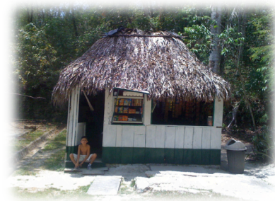
Fotografía 51. Edificación con cubierta de "guano". Fuente: Archivo personal.
