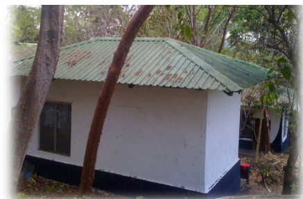
Fotografía 48. Construcciones de bajareque y estructura metálica. Fuente: Archivo personal.
