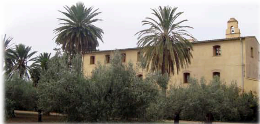
Fotografía 40, Instalaciones del CEACV, Valencia, España.
