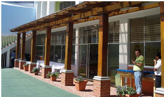
FOTO 81 ACABADOS DEL EDIFICIO
