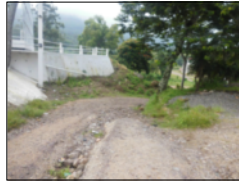
FOTO 48 VISTA INGRESO PEATONAL
