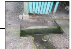
FOTO 46 VISTA DE DRENAJES EXISTENTES
