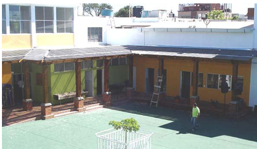
FOTO 75 ESTRUCTURA DEL EDIFICIO
