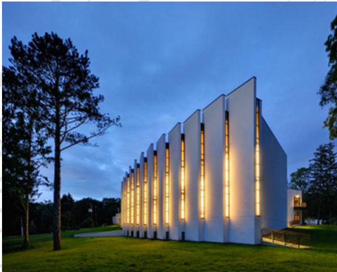
Fotografía 18. Fachada posterior del templo
