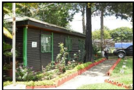
3. Jardines exteriores y madera en las fachadas.
