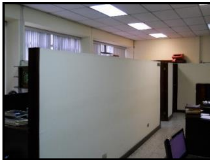
5. Oficinas de administración donde usan muros bajos para permitir la ventilación. Como acabados, cielos falsos tradicionales y el piso es de granito.
