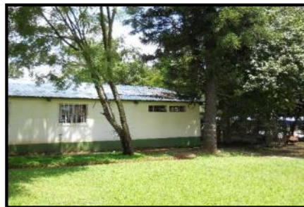
Algunas fachadas con mampostería y repello.
