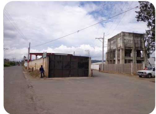
Vías de acceso asfaltadas desde la carretera interamericana CA-1 que convergen en el ingreso al terreno. IMAGEN NO. 7 - Foto Propia
