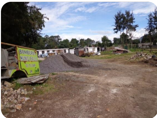
Existe acumulación de ripio y materiales pétreos colocados en el terreno sin control alguno. IMAGEN NO. 17 - Foto propia
