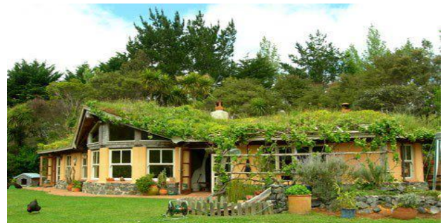
Imagen.7 Bio-Construcción. Fuente: http://viviendapasiva.cl/arquitectura-pasiva/casas-organicas/#.Unu0S3C9Rn1
