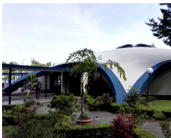
Figura 11: Salón de Actos de la Facultad de Veterinaria “Iglú” Universidad de San Carlos de Guatemala. (1,958: Arquitecto Pelayo Llerena Murua). Fotografía por Oscar Sologaitoa.
