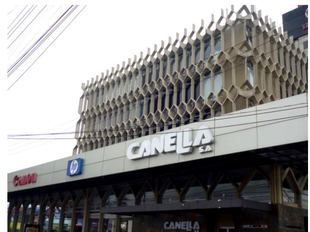
Figura 16: Edificio Canela. (1968: Raúl Minondo Herrera) Fotografía por Oscar Sologaiosta.
