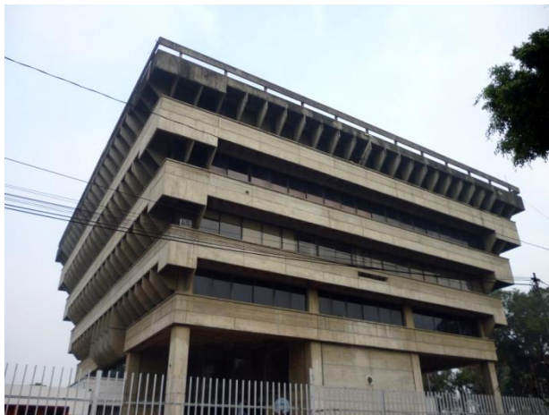
Figura 24: Edificio del Instituto de Fomento Municipal, INFOM (1974: Santiago Tizón Chocano y Carlos Ogarrio Olivero). Fotografía por Oscar Sologaistoa.
