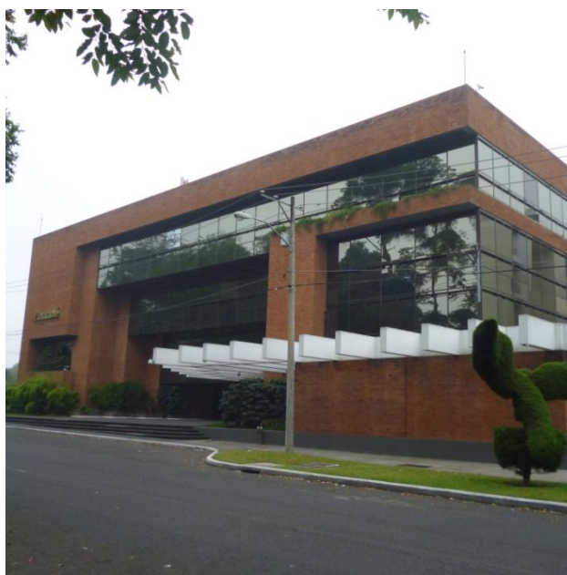
Figura 33: Edificio ANACAFE. (1,991: Castillo & Palma, Montes y Porras y el Arq. Peter Gisemann). Fotografía por Oscar Sologaistoa.
