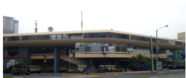
Figura 24: Edificio El Patio. (1974-1975: Arq. Alfonso Yurrita Cuesta y Carlos Rigalt Dolz). Fotografía por Oscar Sologaiosta.
