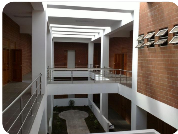
IMAGEN NO. 17 corredores edificio de administración y aulas INTECAP Huehuetenango Fuente: propia, visita de campo
