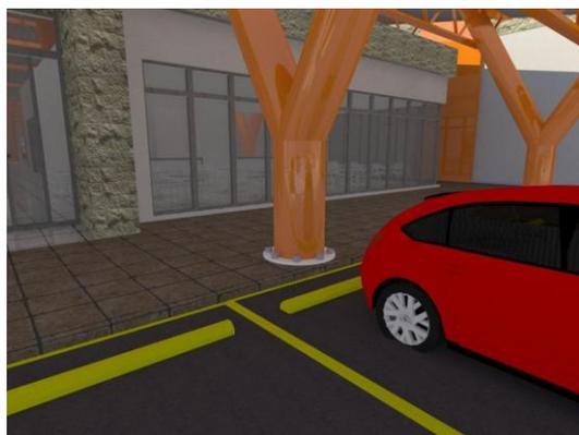
Se maneja estructura metálica para sostener la cubierta de lámina troquelada perna a los cimientos.
