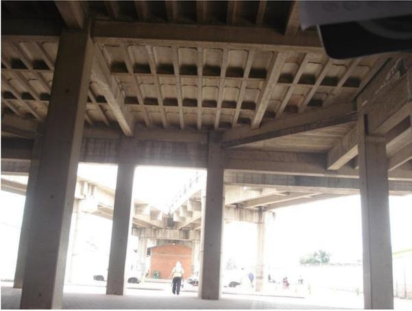
*El sistema estructural utilizado en el proyecto es la losa con molde LK y con apoyos a cada 10 m. de concreto reforzado.*
