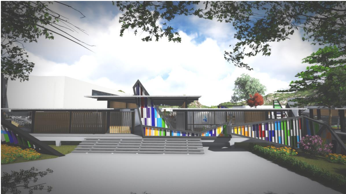
Vista de Ingreso a Talleres, desde 5ª calle.
