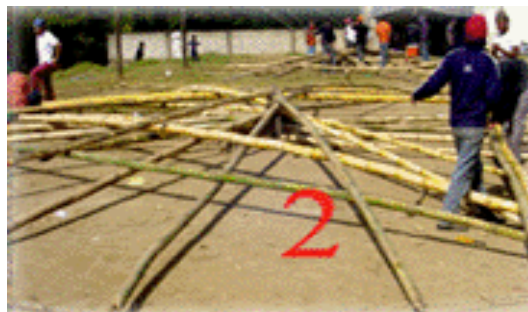
12. Estructura de Barrilete
