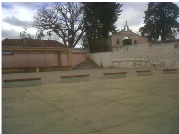
2. Plaza de ingreso a Cementerio Municipal, deterioro de la infraestructura
